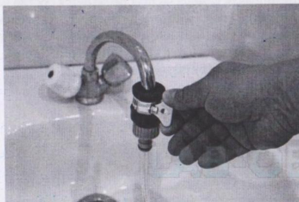
Рис 5. Установка шланга на водопроводный кран.
